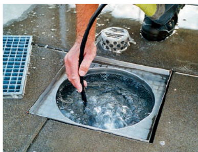
Nettoyage sous haute pression d'un dispositif d'évacuation des eaux obstrué.
